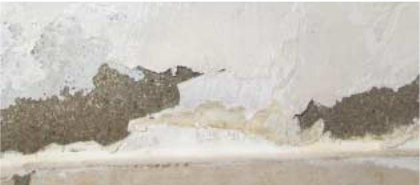
Jeder kann die Feuchtigkeit in seiner Wohnung selbst prüfen. Bereits einfache Feuchtigkeitsmessgeräte (Hygrometer) geben eine Orientierung über die relative Luftfeuchtigkeit im Raum. Sie sollte auf Dauer 65-70 % in der Raumluft und unmittelbar entlang von Wandoberflächen 80 % nicht überschreiten, um die Gefahr von Schimmelpilzwachstum zu verringern.
