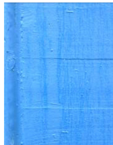
Streifenbildungen auf einem blauen Dispersionsanstrich infolge von Tauwasser-Ablaufspuren!
