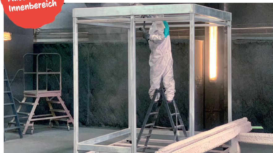
Nach Vorbehandlung mittels Eisstrahlen werden verzinkte Unterstände in einem Arbeitsgang mit RUCOPUR HS 2in1 appliziert.
